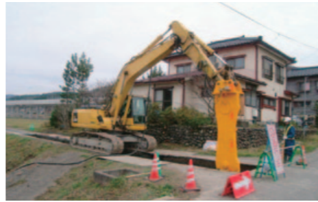
民家の近接部における改良施工
